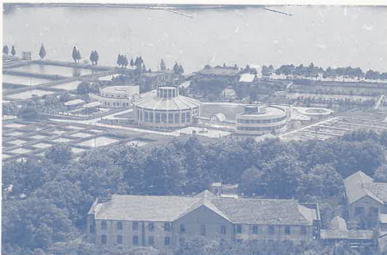
The Wuhan Institute of Hydrobiology. 武漢科學院水生生物研究所。
